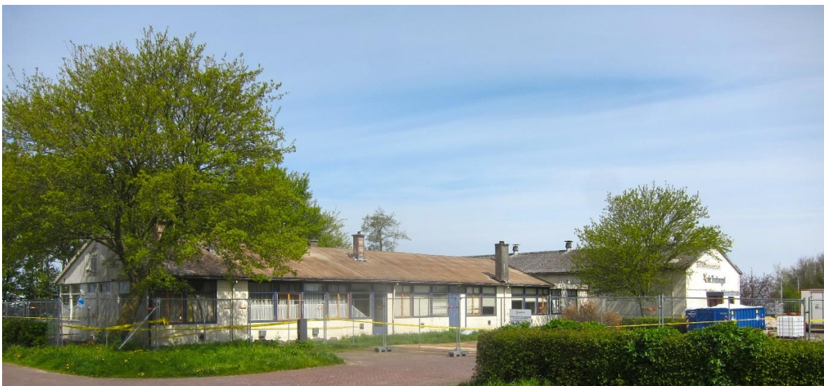
Het voormalige RIJP-gebouw op 27 april.
