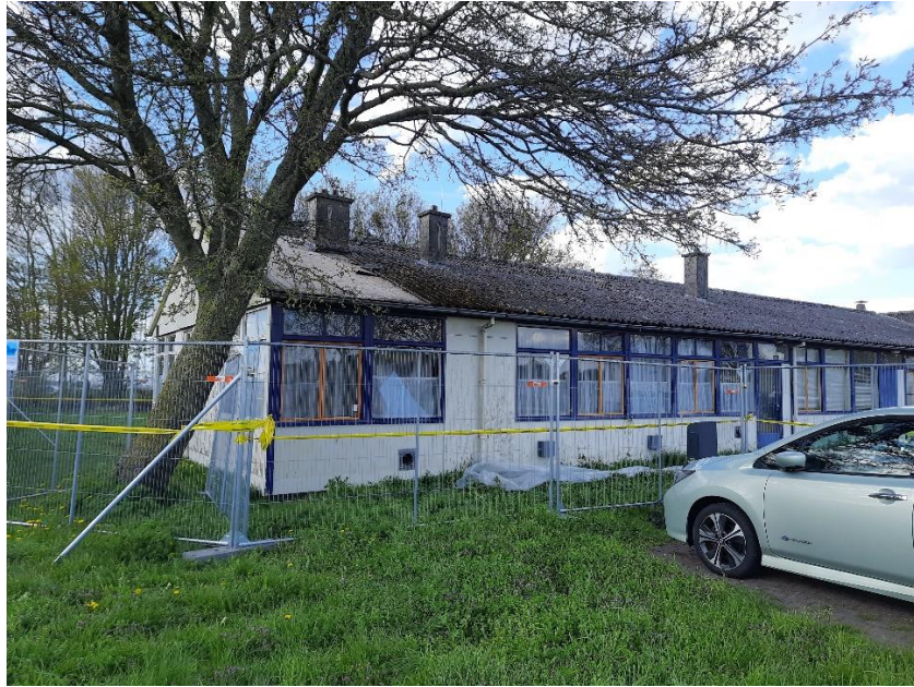
Het voormalige RIJP-dienstgebouw op 14 april 20 uur. De eerste asbestplaten zijn verwijderd.
